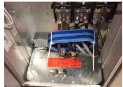
〈 Common-mode 필터 설치 〉
